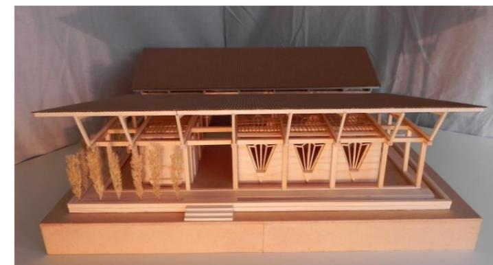
La forma e l'orientamento del complesso scolastico sono stati studiati per controllare l'incidenza della luce solare durante le ore più calde della giornata senza compromettere l'illuminazione naturale delle aule. Pertanto, nei quadranti est e ovest, verranno posizionate le finestre delle aule e nel quadrante sud verranno posizionati i compartimenti per le restanti aree proposte.
